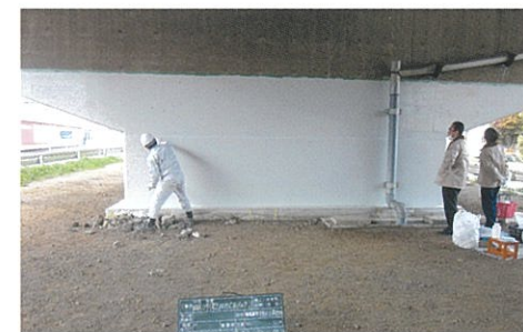
落書き防止工法
