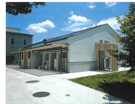
※(独)森林総合研究所 環境計測棟 (茨城県つくば市)
