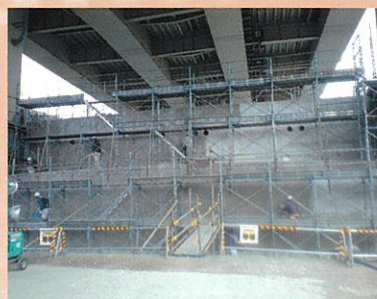
横浜湾岸道路橋台 (神奈川県横浜市)
