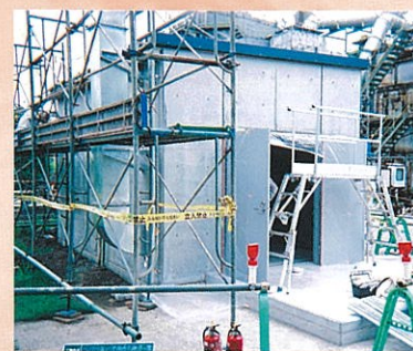
化学工場倉庫 (千葉県袖ヶ浦市) 日本有数の大工場保管庫にセラグシタールPRO施工。 施工してもコンクリートの質感は変わりません。
