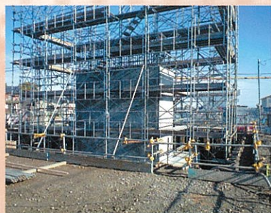
圏央道須郷高架橋 (埼玉県久喜市)
